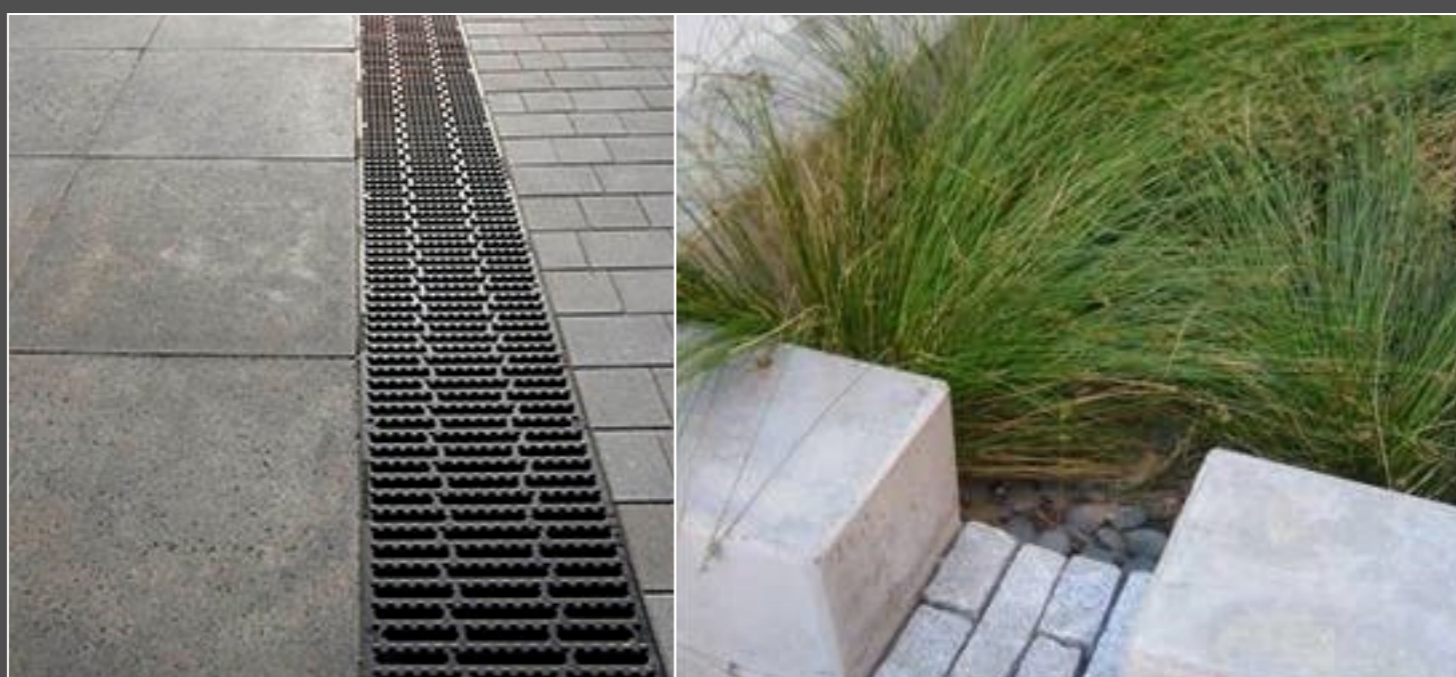
Detaljeringsseksempler : til venstre linjedræn i belægning og til højre åben kantsten til regnbedet.
