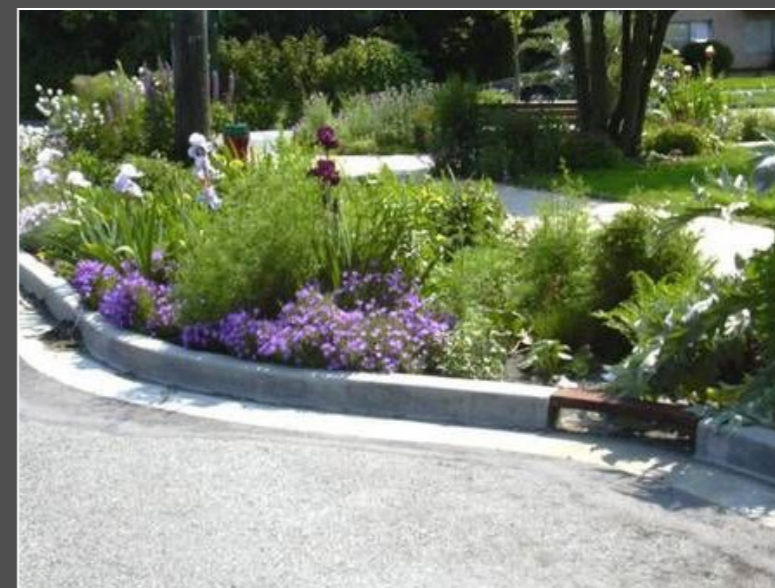
Regnbed med varieret beplantning og indløb gennem åben rist.
